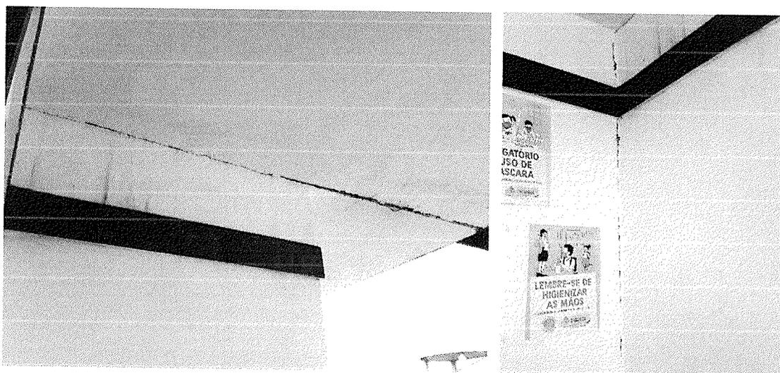
Figura 5-2 – Juntas de dilatação
